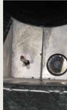
Detail protipožární sondy a požárního zařízení.
