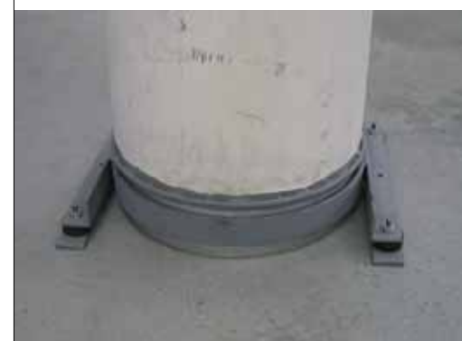
Usazení trubek v upevňovacím rámu.
