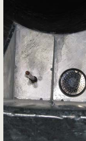
Detail protipožiarnej sondy a požiarneho zariadenia.
