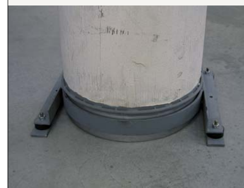
Vsadenie trubiek v upevňovacom ráme.
