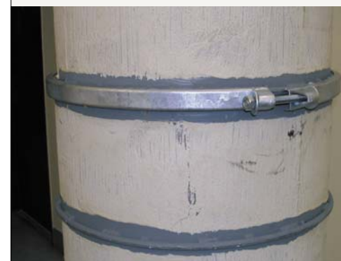
Sťahovacia spona na spojoch trubky.
